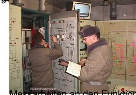
96. Messarbeiten an den Funktionsanzeigen durch den Wartungstrupp
