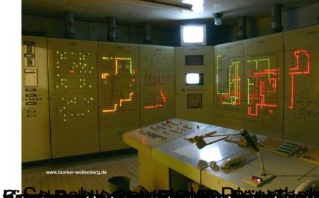
97. Die Funktionsanzeigen zeigen den Status der verschiedenen Funktionen an. Rotes Licht deutet auf einen Fehler hin, gelbes Licht auf einen Warnzustand.
